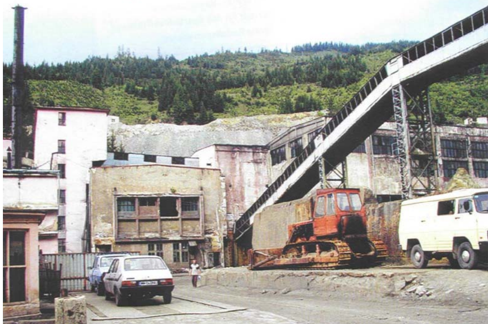
Erz-Flotationsanlage bei Baia Borsa „Hunderte Hotspots, die dringend einer Sanierung bedürfen“
